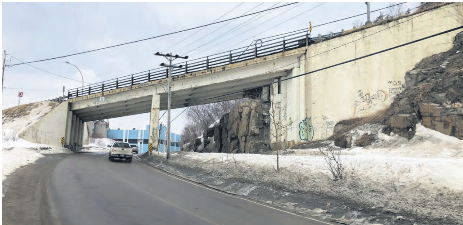
Selon le ministère des Transports du Québec, les travaux de réfection du viaduc de l'avenue de Maisonneuve sont de nature préventive principalement.
