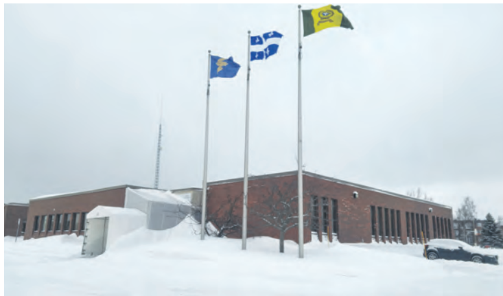
La nouvelle installation de 45 places en services de garde subventionnées sera créée dans l'édifice du 1000, rue Mingan, qui appartient à la Ville de Baie-Comeau et dont le CPE Magimuse sera locataire.
