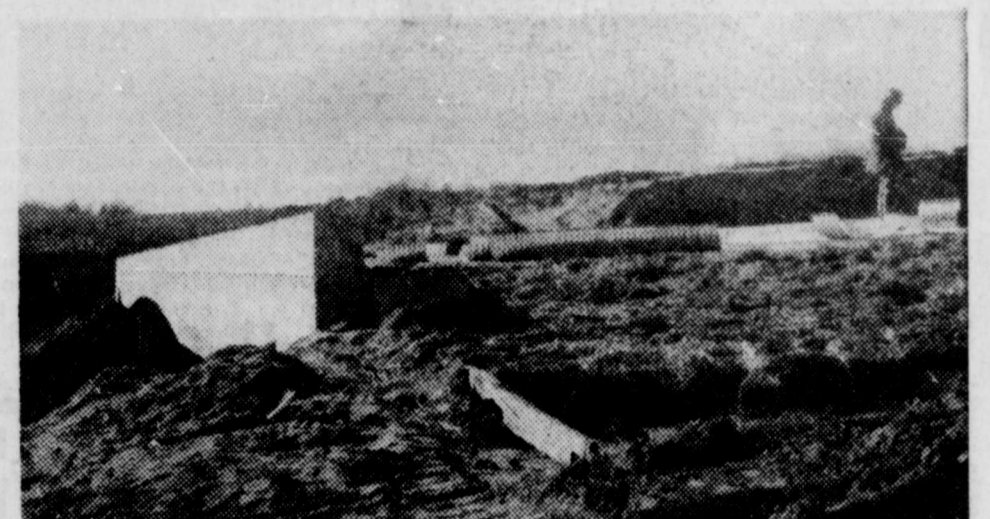
La firme Arco Construction de Plessisville termine les travaux de construction d'un nouveau pont qui enjambe la rivière des Pins, dans la ville de Warwick. C'est à cet endroit que passera l'an prochain la nouvelle route 5. Le contrat d'Arco Construction était de $177,000. (Photo LeRo)
