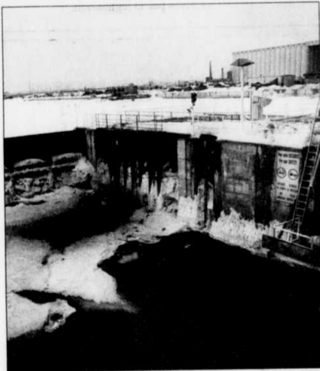
Un trou énorme s'est creusé sous l'écluse centenaire.
