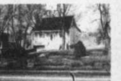
16 - BORD DE L'EAU: Cottage rénové, 15 400 pi.ca. sur le bord du Richelieu. JEAN-GUY BEAUDET, 467-1120.
