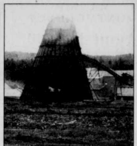
Le brûleur à déchets ligneux de la scierie Delebo, à Nouvelle.
