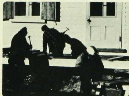
L'ÉQUIPE DE CONSTRUCTION
