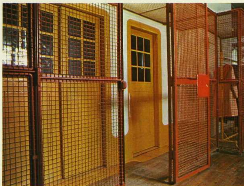
On a conservé les grilles qui servaient anciennement quand les locaux étaient un entrepôt de fourrures.
