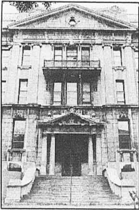
La travée centrale du corps principal, une magnifique réussite architecturale d'inspiration néo-classique, signée Émile Vanier.
