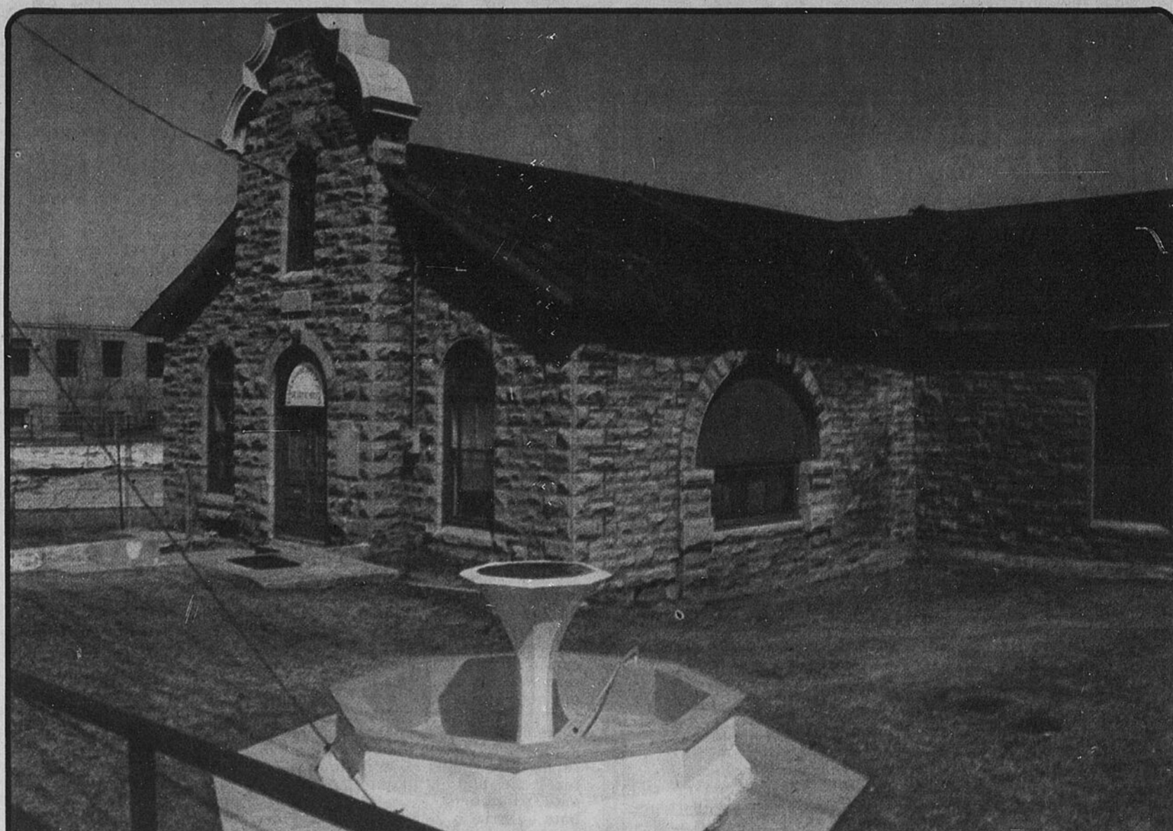
Plus de $500,000 provenant de la ville de Hull, du fédéral et du gouvernement provincial serviront à «refaire une beauté» du Château d'eau construit au début du siècle à Hull. (Photo LE DROIT par François Roy)
