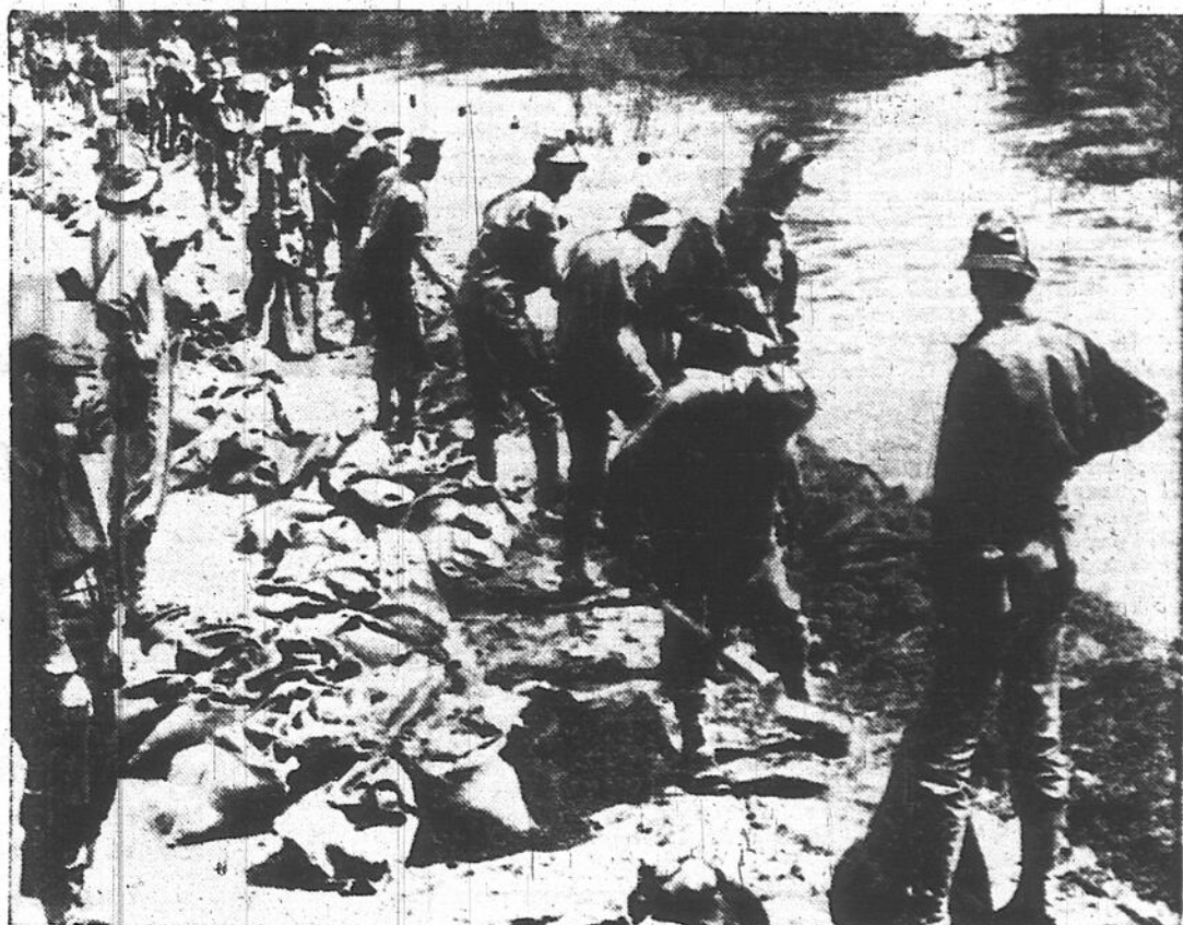
Le corps de génie de l'armée américaine construit un rempart pour arrêter la crue des eaux de la rivière Boisé, qui dépasse le niveau des basses terres près de Cowen Field, Idaho. Plus de 150 familles durent évacuer leurs propriétés. La crue menaçait plusieurs ponts.
