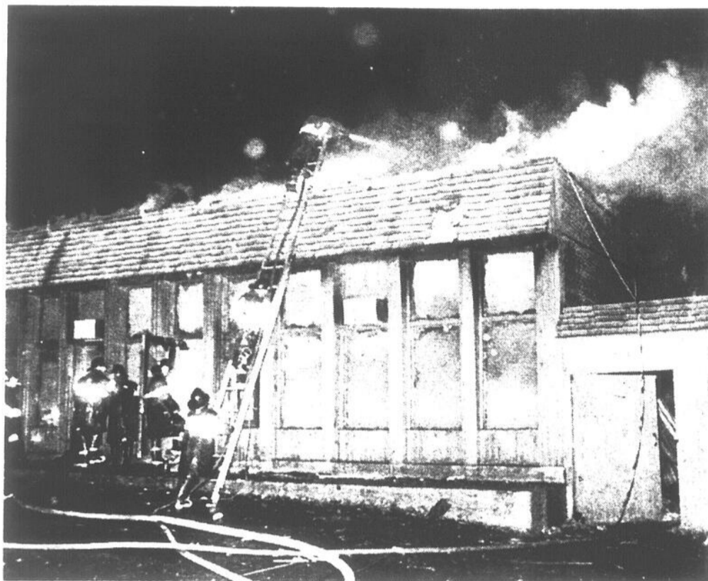
Le feu a causé des dommages évalués à $1 million dans un centre de rénovation de Saint-Bruno.
