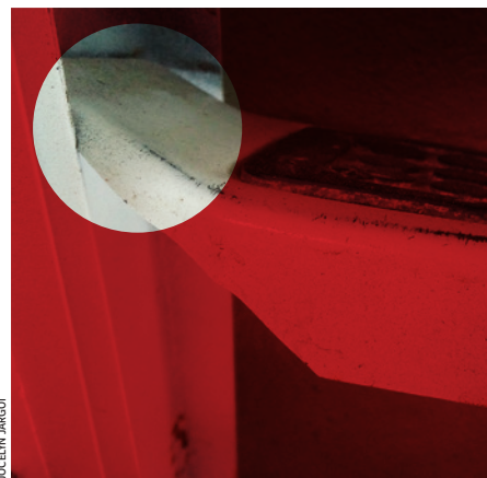
Vue de loin, cette marche semble en bon état. En y regardant de plus près, on s'aperçoit qu'elle est partiellement dessoudée.
