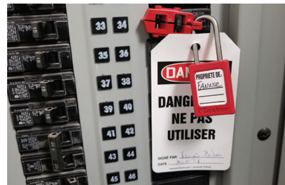
Cadenas pour disjoncteur dans le panneau de la salle électrique
