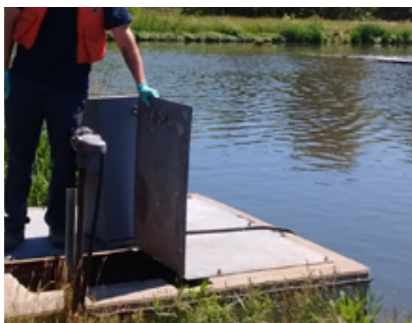
Photo 6.2. Exemple d'un déversoir avec paroi verticale
