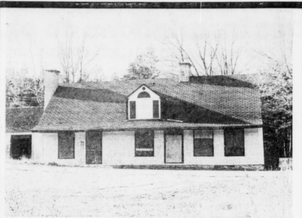
La maison Dery avait cette allure avant que ne débutent les travaux de restauration, au coût de $228,000.
