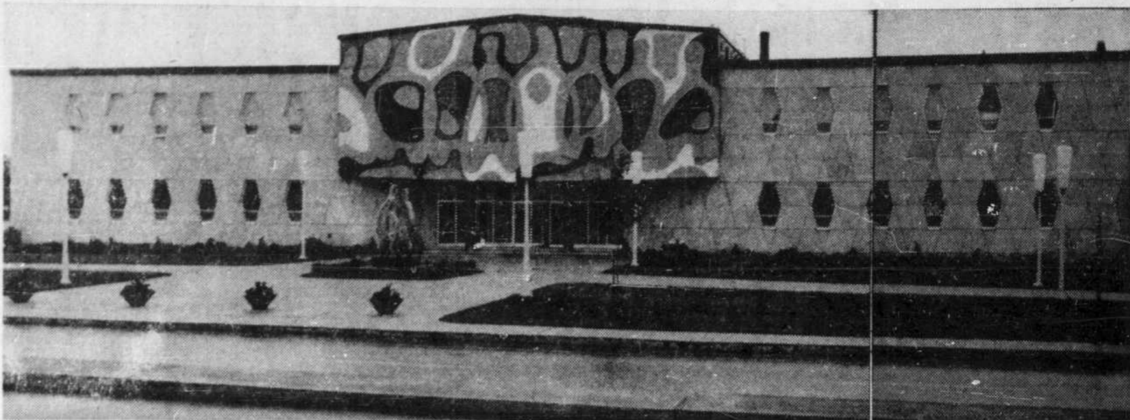
Ce magnifique Centre culturel et sportif, au service des membres des corps de métiers de la construction, est sous la direction de M. Gilles Houde, diplômé en éducation physique de l'université de Floride. Ce Centre ultra moderne de loisirs est situé à l'angle du boul. St-Joseph et Parthenais à Montréal.
