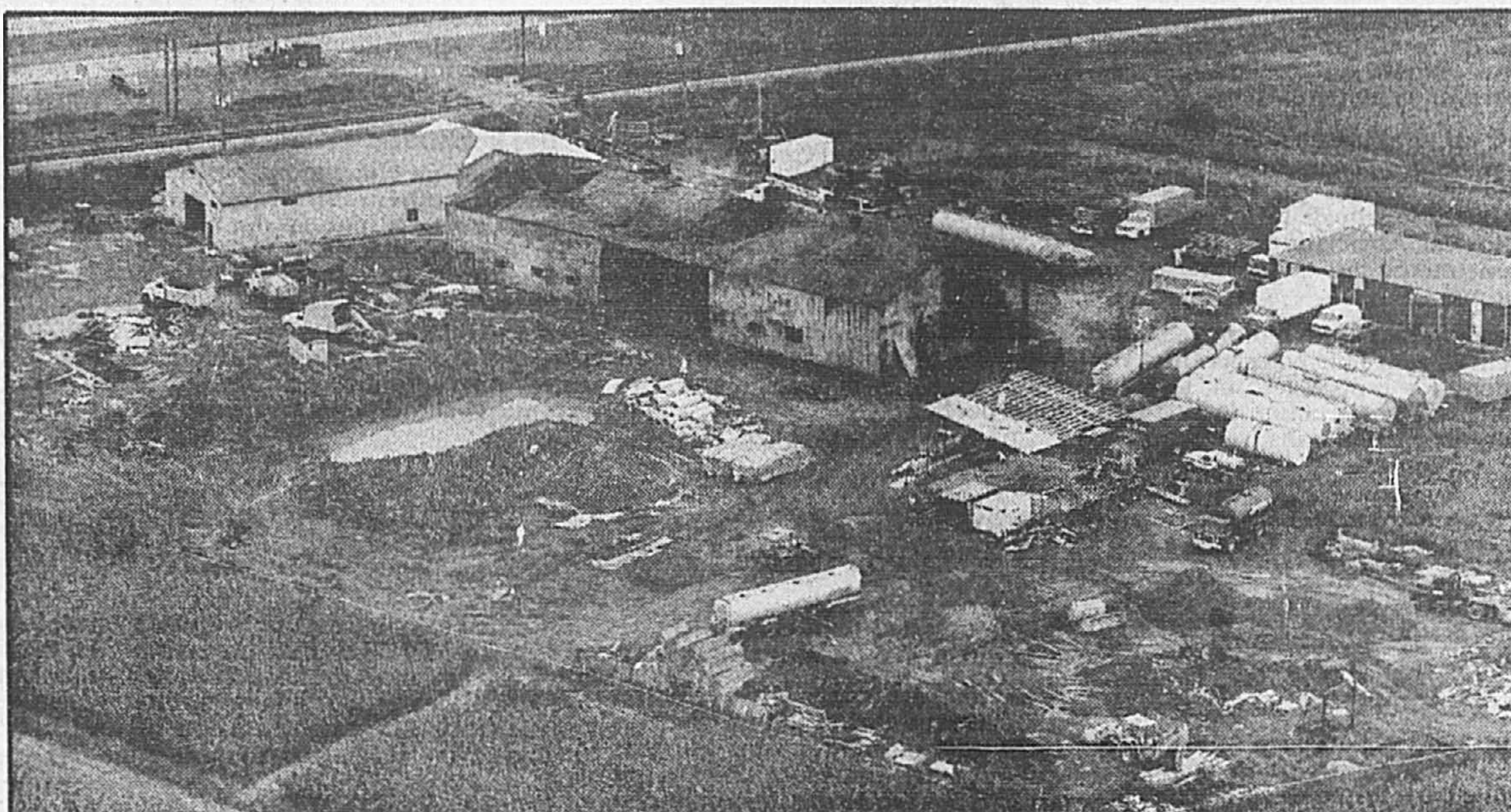
Au centre, on peut voir l'entrepôt incendié, qui n'était gardé par aucun système d'alarme le soir de l'incendie.
