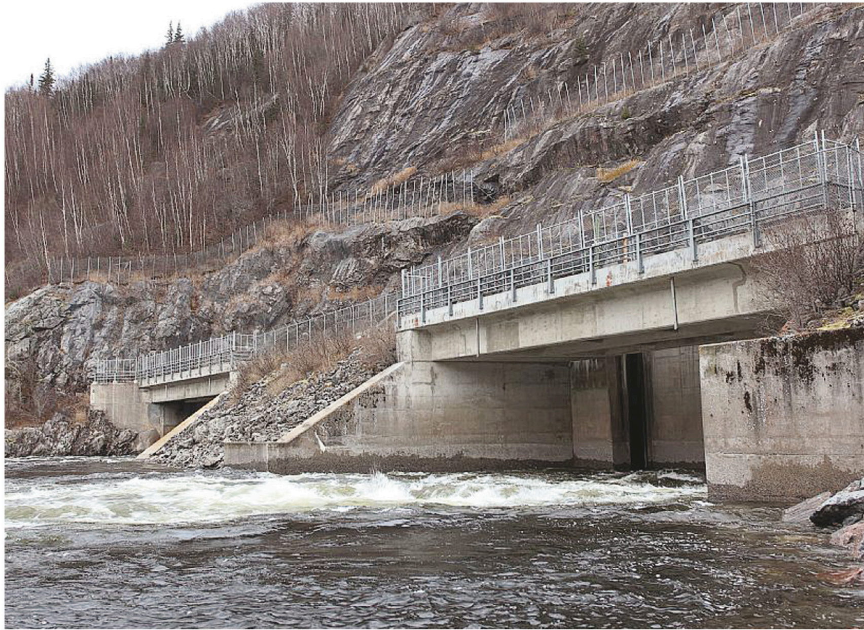
Sortie du conduit d'eau utilisée pour produire l'énergie de la centrale avant d'être réacheminée au fleuve Churchill
