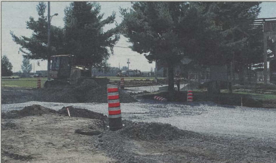
Des travaux de réfection des chemins sont aussi en cours.
