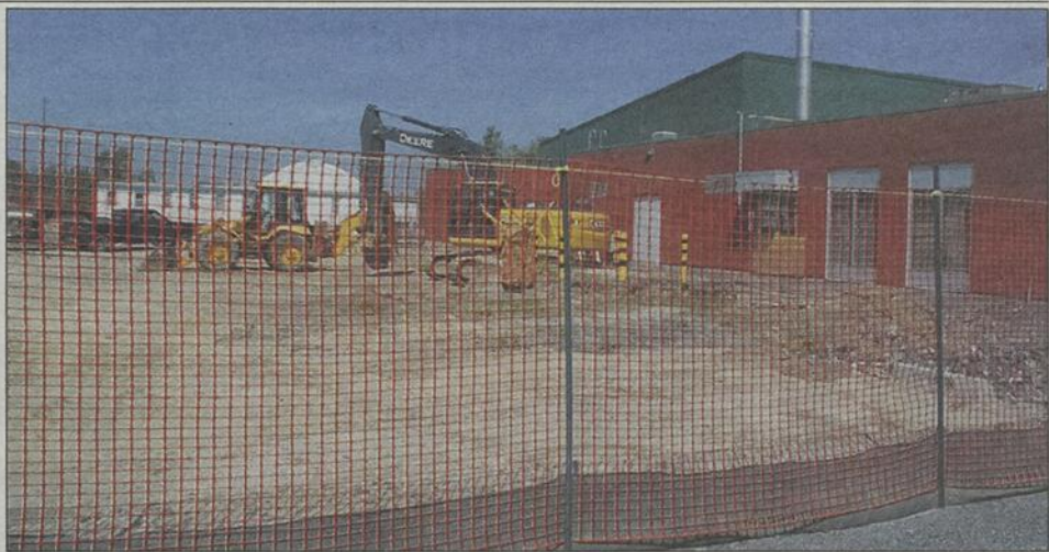
L'édifice multifonctionnel abritant un gymnase, des salles de cours et les bureaux est aussi agrandi.
