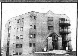
RIVIERE-DU-LOUP: Boul. Thériault: Condo 4 1/2 pièces avec accès au garage. Entièrement aménagé. Situé au 1er étage. (3137)
