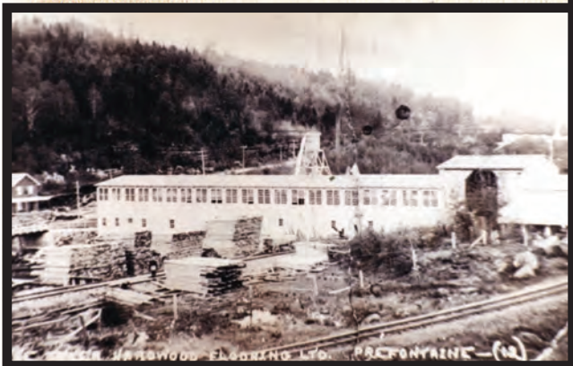
Les moulins de la Tyler Hardwood Flooring à Préfontaine vers 1925-1926. On remarque à gauche le pont Marier dit Préfontaine, ainsi que la maison du gérant de l'entreprise (maison toujours existante) et la voie parallèle pour le chargement des wagons. (Collection Louis Pelletier)
