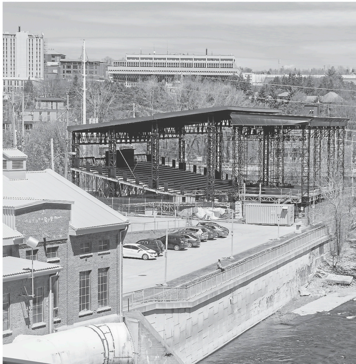
Le théâtre de la place Nikitotek devra être déplacé à la fin de la saison estivale pour permettre la construction du pont des Grandes-Fourches. — PHOTO ARCHIVES LA TRIBUNE
