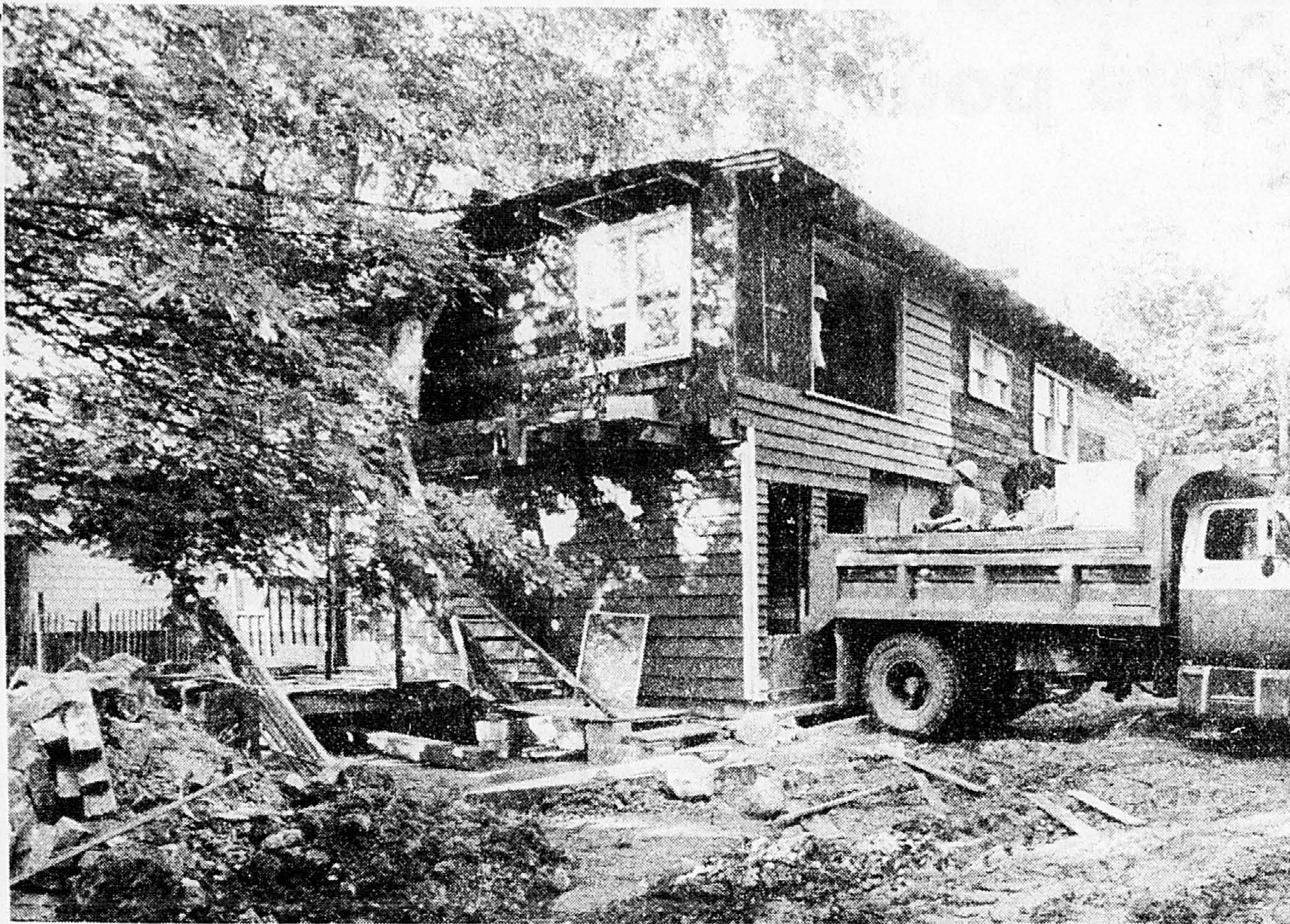
Dernière étape avant la démolition, des employés municipaux déménagent le mobilier des Mordiko.
