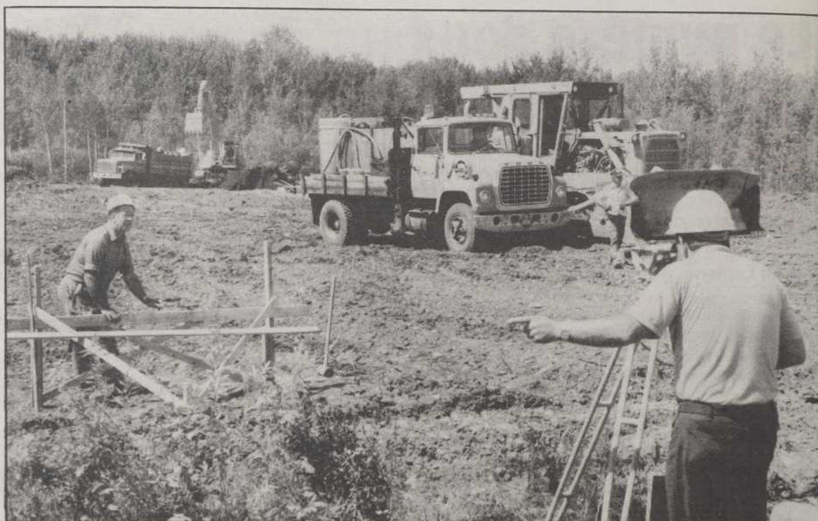
Le nouvel entrepôt de distribution de la brasserie Molson de la fromagerie d'Agropur. O'Keefe est en construction rue Bernard, à quelques mètres
