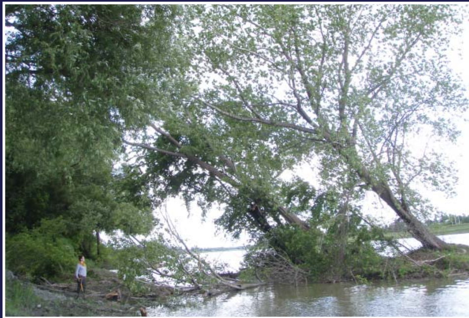
Glissement de terrain, en bordure de la rivière Yamaska, dans des sédiments silto-argileux de la Mer de Champlain.
