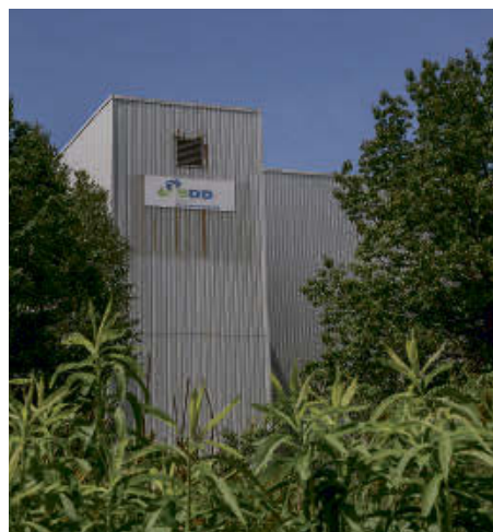
La bâtisse abritant autrefois SDD/Conporec, en bordure de l'autoroute 30, n'accueillera finalement pas l'entreprise Absolu technologies de recyclage.
