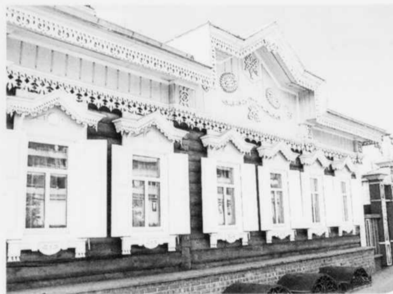
L'isba se distingue par ses fenêtres délicatement ouvragées.
