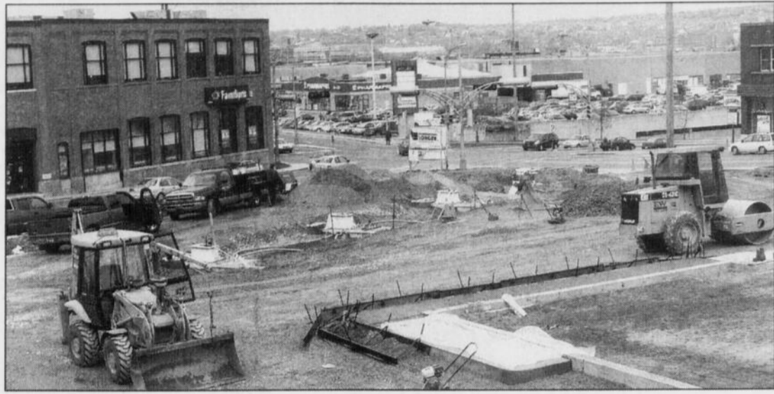
On trouve au moins trois importants chantiers de construction depuis quelques semaines dans le secteur Galt-Belvédère. Ces dernières années, le montant total des investissements frise les 10 millions $.
