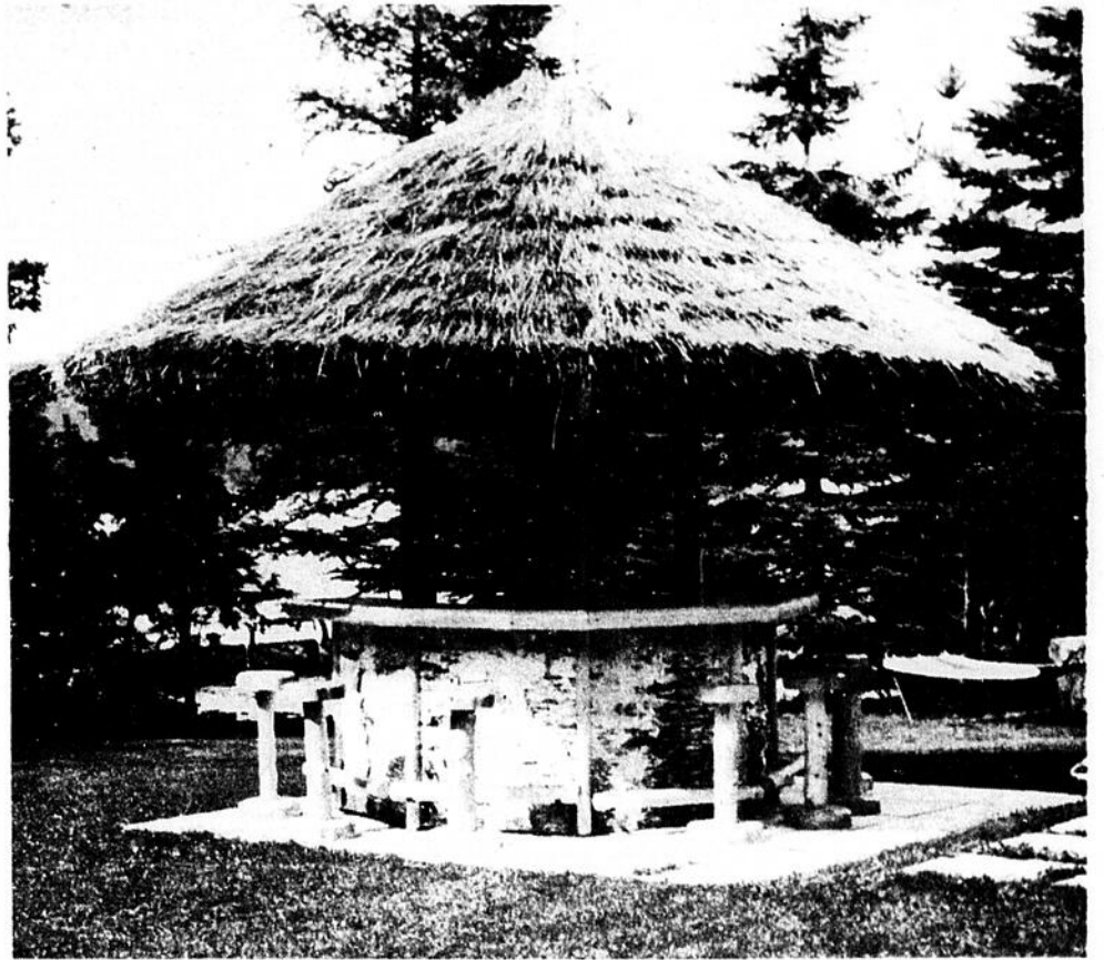
Une des plus belles réussites de M. Bouchard de Baie-St-Paul. Un bar extérieur, couvert d'un toit de chaume. Tout a été fait entièrement à la main, même la préparation du chaume. Cet ornement pratique est d'un charme exclusif.
