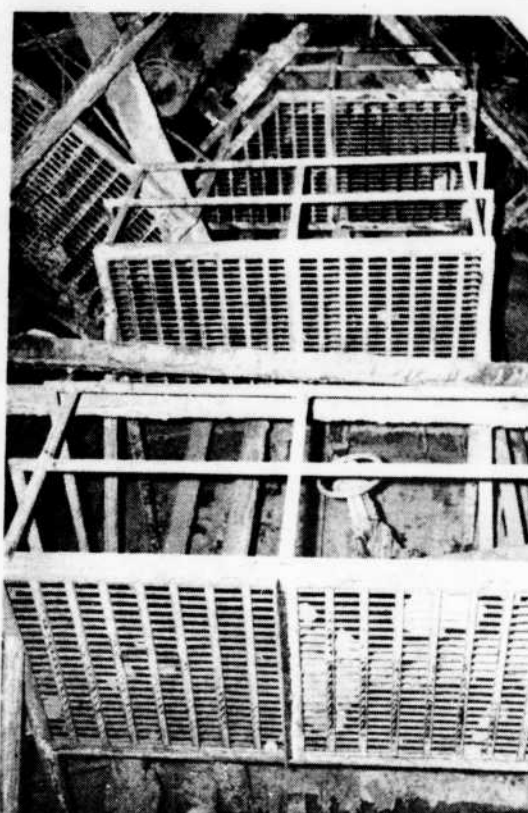
APRES — Quelques jours plus tard, les mêmes tuyaux du même réservoir, mais avec leurs passerelles maintenant installées.
