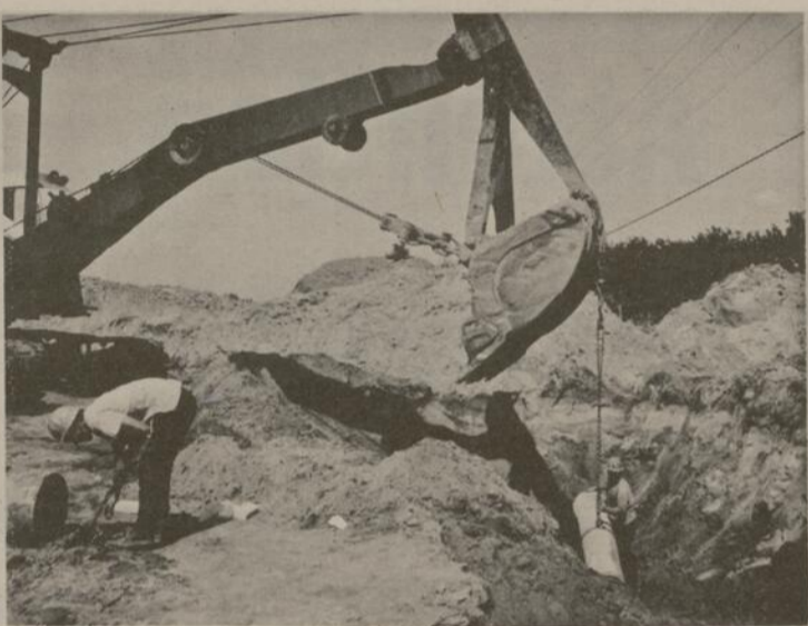
250 pieds par jour. Tel est en moyenne la progression des travaux près de la Place Le Marquis à Nicolet. On voit ici M. Robert Hamel et M. Georges Mondoux occupés au posage de tuyaux d'aqueduc, d'égoûts de surface et d'eau usée. La firme Piercon Ltée a déjà complété une bonne partie des travaux.
