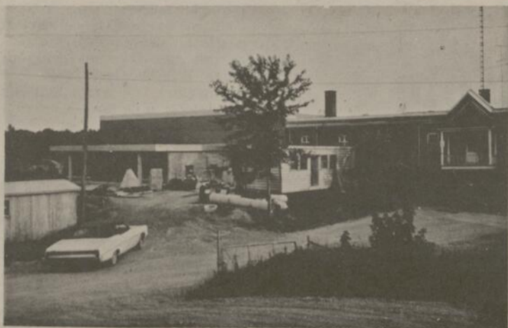
Voici où en sont les travaux du nouveau filtre de Nicolet. L'Entreprise Roland Duval Inc., de Nicolet effectuera également les travaux de construction d'un barrage où la réserve d'eau sera d'environ 500,000 gallons alors que le filtre pourra traiter jusqu'à un million de gallons d'eau par jour.
