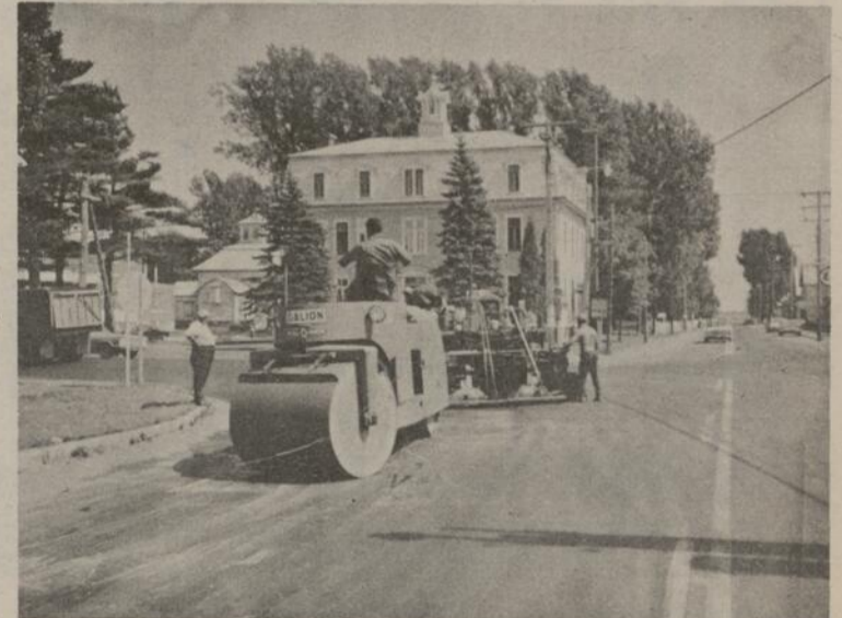
C'EST SERIEUX.— A St-Célestin comme ailleurs, l'équipement lourd ne chôme pas. M. Louis Girard, (à gauche) surveille les mouvements de cette machinerie alors que les travaux de réfection sont commencés sur la route 34.
