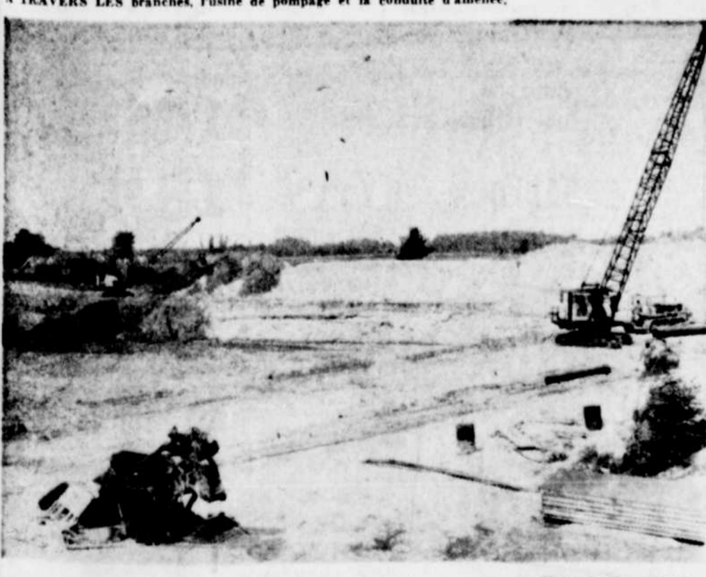
L'EXCAVATION DU réservoir dont le coulage commencera cette semaine.
