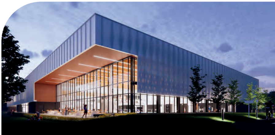
Vue du bâtiment de l'extérieur
