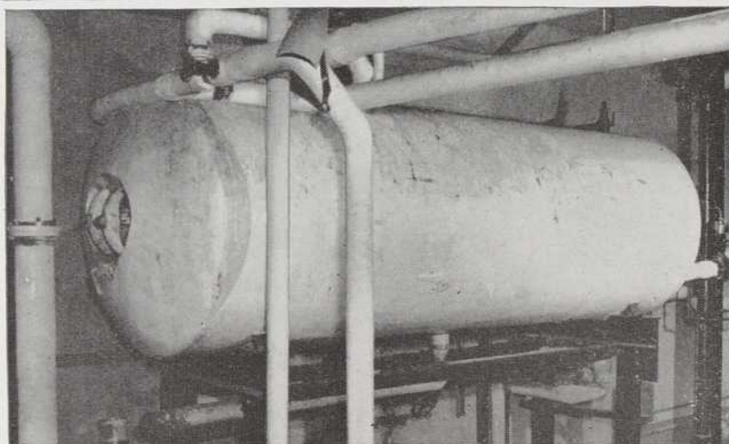
Vue montrant un réservoir à eau chaude en MONEL après son installation à l'Hôpital Général de la Miséricorde, à Montréal.
