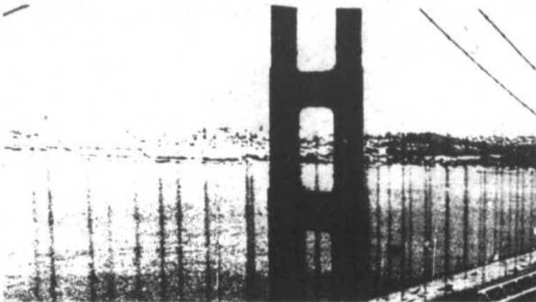
L'un des plus célèbres ponts au monde, le Golden Gate à San Francisco. (Photo San Francisco Convention and Visitors Bureau)
