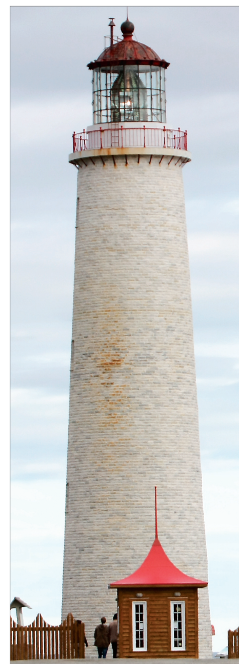
Quelques visiteurs s'apprentent à entrer dans le phare de Cap-des-Rosiers en ce milieu d'automne. Malgré des signes de détérioration évidents, le bâtiment a attiré environ 1 000 visiteurs de plus cette année. GILLES TREMBLAY
