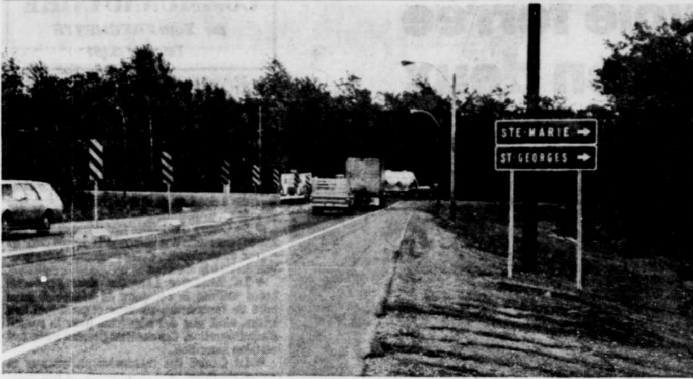
Le prolongement de l'autoroute Robert-Cliche sur une distance de 18,2 km coûtera près de $17 millions.
