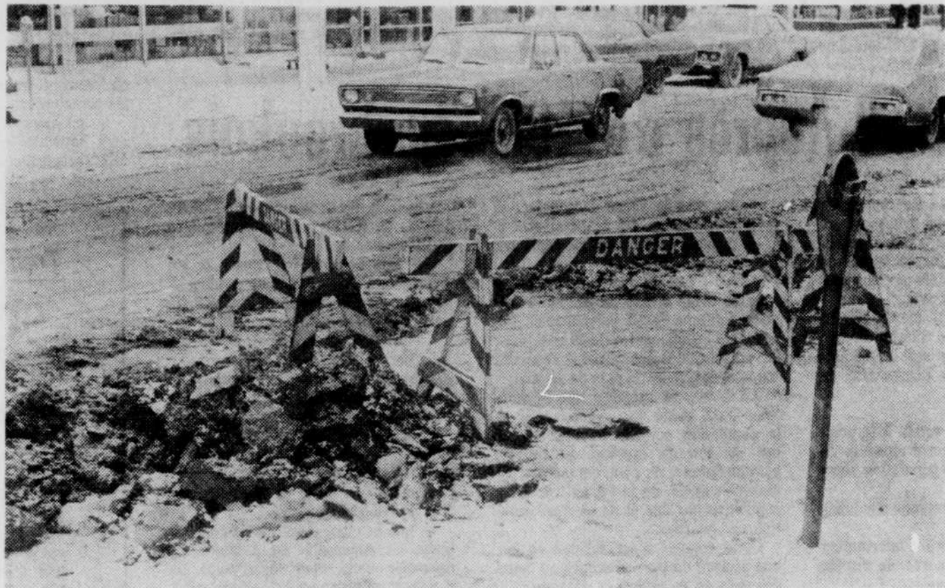
Quelque chose est défectueux dans le système d'aqueduc de la rue Notre-Dame. Un tuyau a dû éclater vu la quantité d'eau qui s'échappe à la surface. (Photo La Tribune, F. L., Victoriaville)
