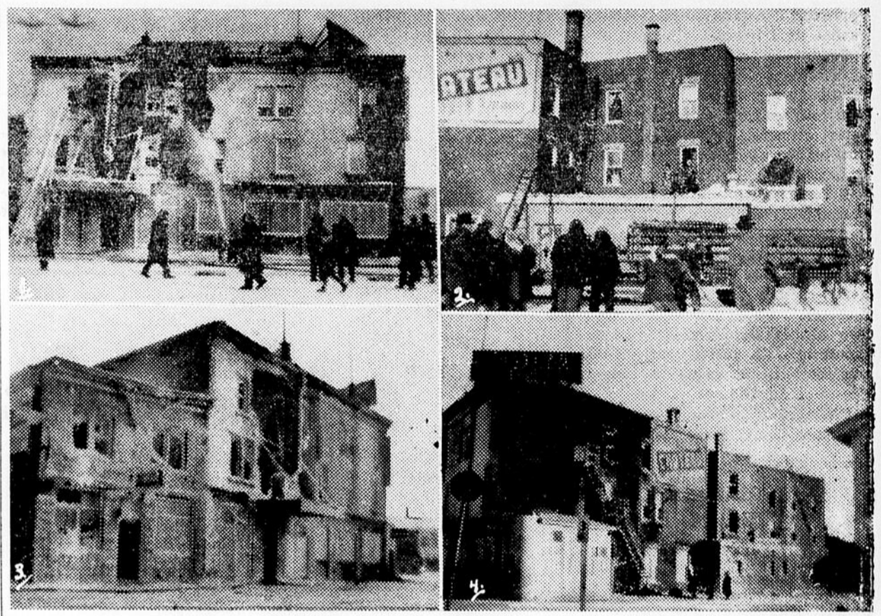
Le feu a causé pour plus de $100,000 de dommages au Château Salaberry à Valleyfield mercredi, le 12 janvier dernier. Nos pompiers ont grandement contribué à arrêter le progrès des flammes par leur beau travail. On remarque au haut, à gauche, les pompiers en face du Château. Après quelques heures de travail. A droite, une équipe d'hommes aide au transport des meubles et effets personnels des pensionnaires. En bas, à gauche, le Château après le départ des pompiers. A droite, le côté est de la bâtisse. (Photos La Gazette de Valleyfield).
