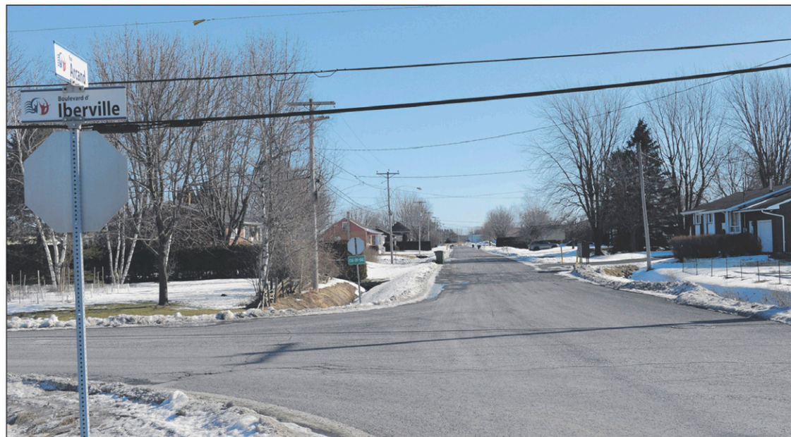
Le nouveau réseau viendra se brancher sur celui du boulevard d'Iberville.
