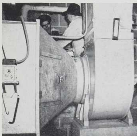
Vue de l'un des énormes souffleurs du système de ventilation de l'hôpital.
