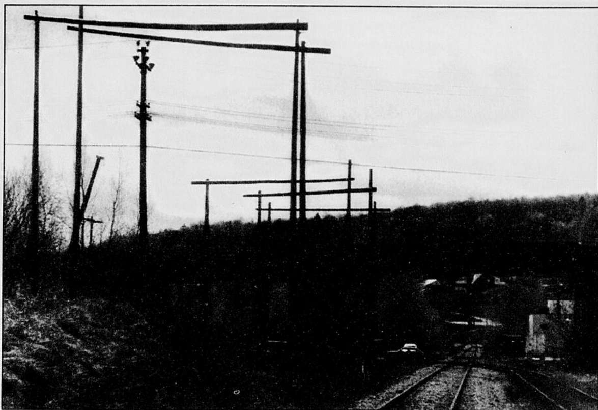
Ces pylônes près de la rivière Saint-François seront remplacés par d'autres d'une hauteur pouvant atteindre 31 mètres.
