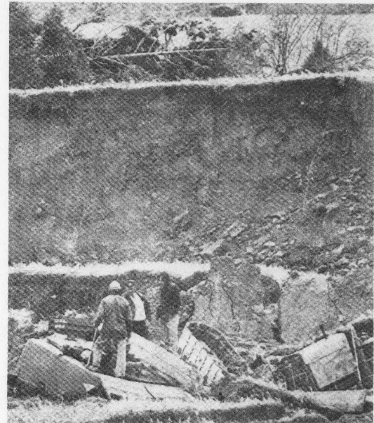
Les secouristes s'affairaient toujours hier soir pour retrouver le corps de M. Yvon Ayotte emporté avec son marteau-pilon dans un important glissement de terrain près de Rigaud. Au moment de la tragédie, ces ouvriers s'affairaient à consolider le sol en y enfonçant des piliers d'acier pour rendre possible l'érection d'un pylone de l'Hydro-Québec. (Photo CP)
