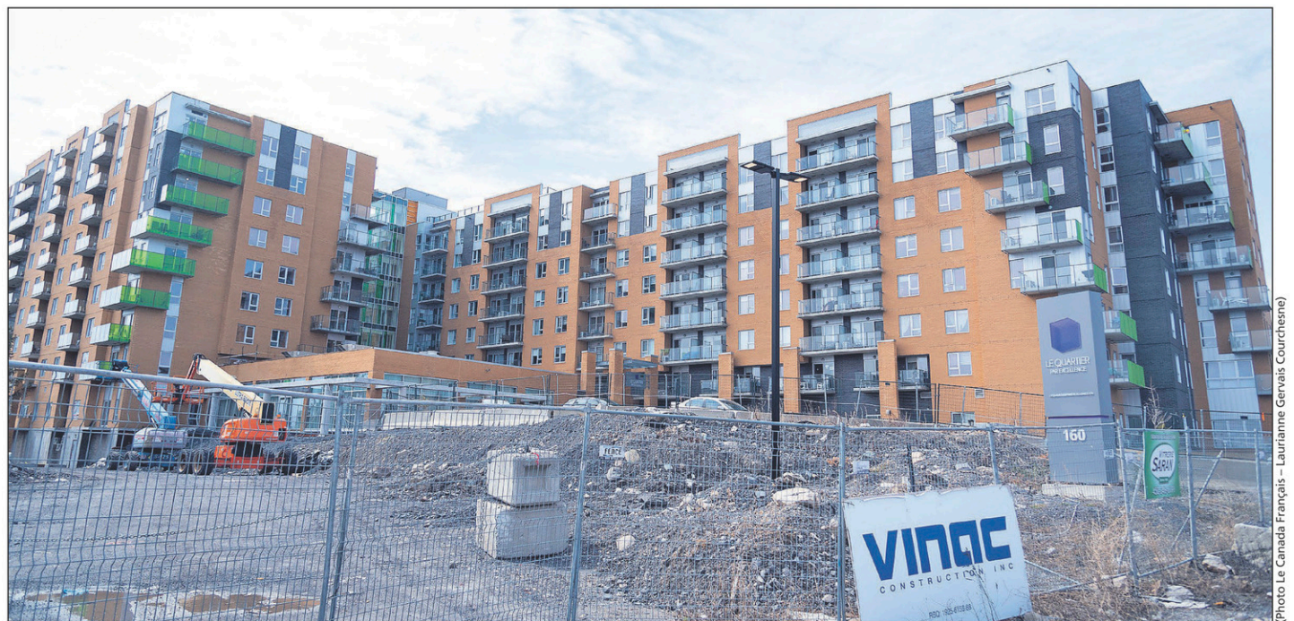
Les travaux pour finaliser la deuxième phase de la résidence Le Quartier par Excellence, située sur le boulevard Saint-Luc, sont suspendus jusqu'à nouvel ordre.
