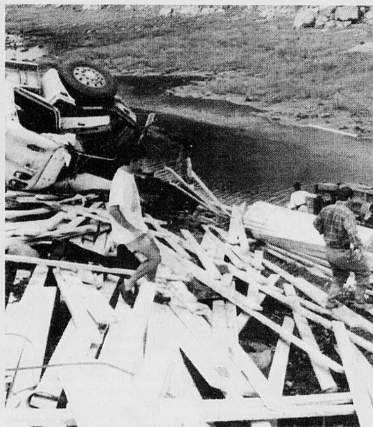
DEMOLITION - La fourgonnette a été complètement démolie sous la force de l'impact. Pour une raison inconnue, le véhicule était stationné en bordure de la route.
