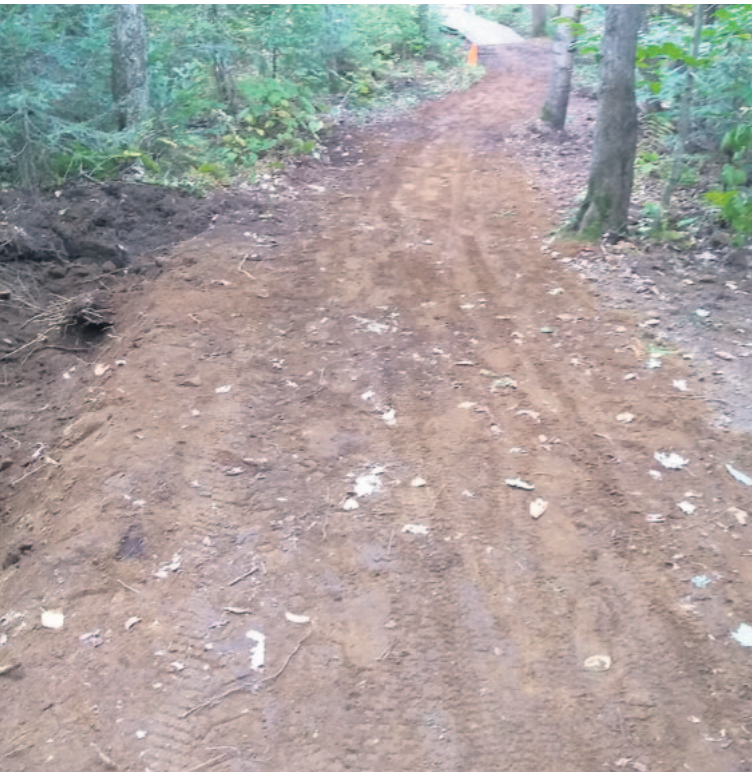
Sentier en terre minérale extraite manuellement à partir d'une section de fossé et de 3 fosses
