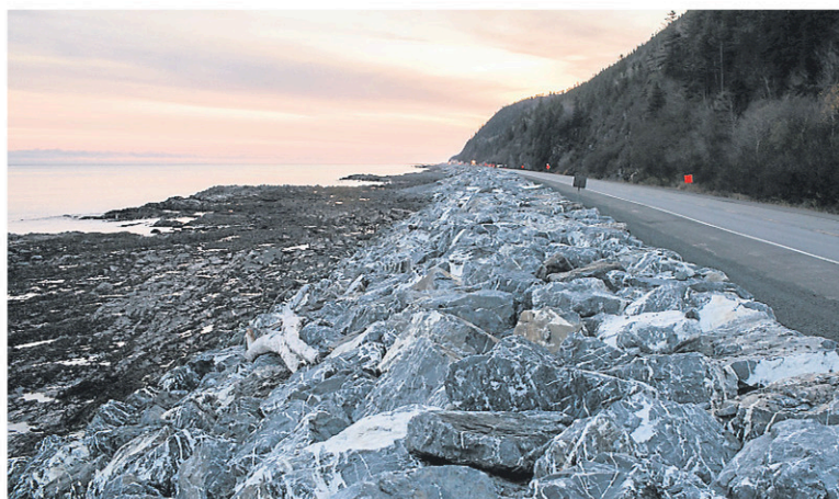
De l'enrochement protège une section de la route 132 à la hauteur de Rivière-à-Claude. À la mi-décembre, les grandes marées ont emporté une section de la route sur la moitié de sa largeur, entre Sainte-Anne-des-Monts et l'Anse-Pleureuse. - PHOTO ARCHIVES LA PRESSE
