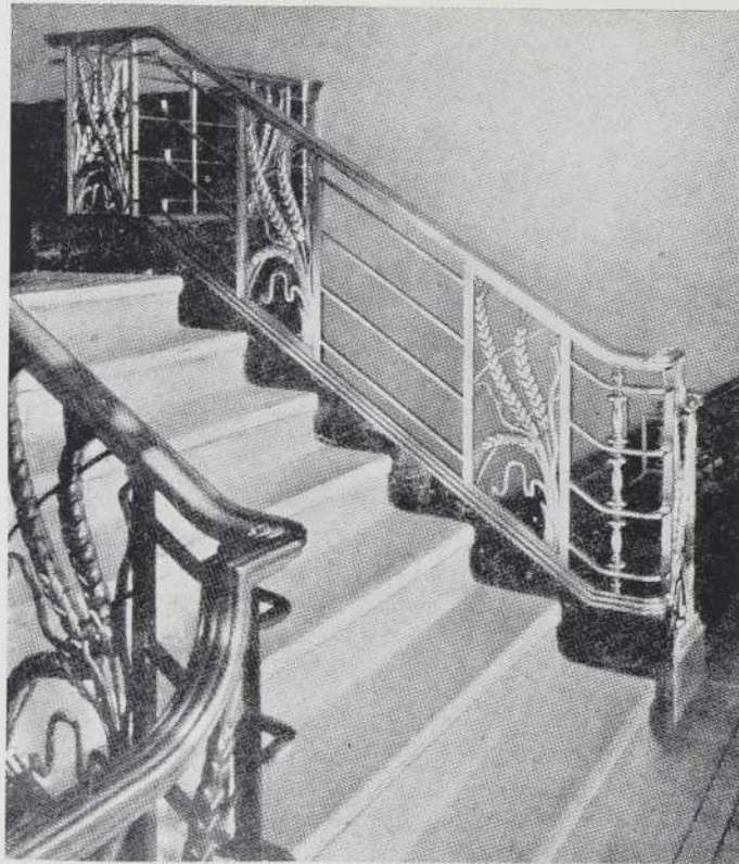
Escalier intérieur en acier et bronze forgé.
