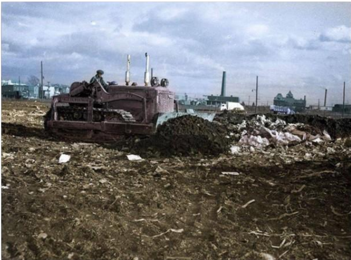
Fin du remblaiement de la carrière Martineau (circa 1952-53). Source : Archives ShRPP
