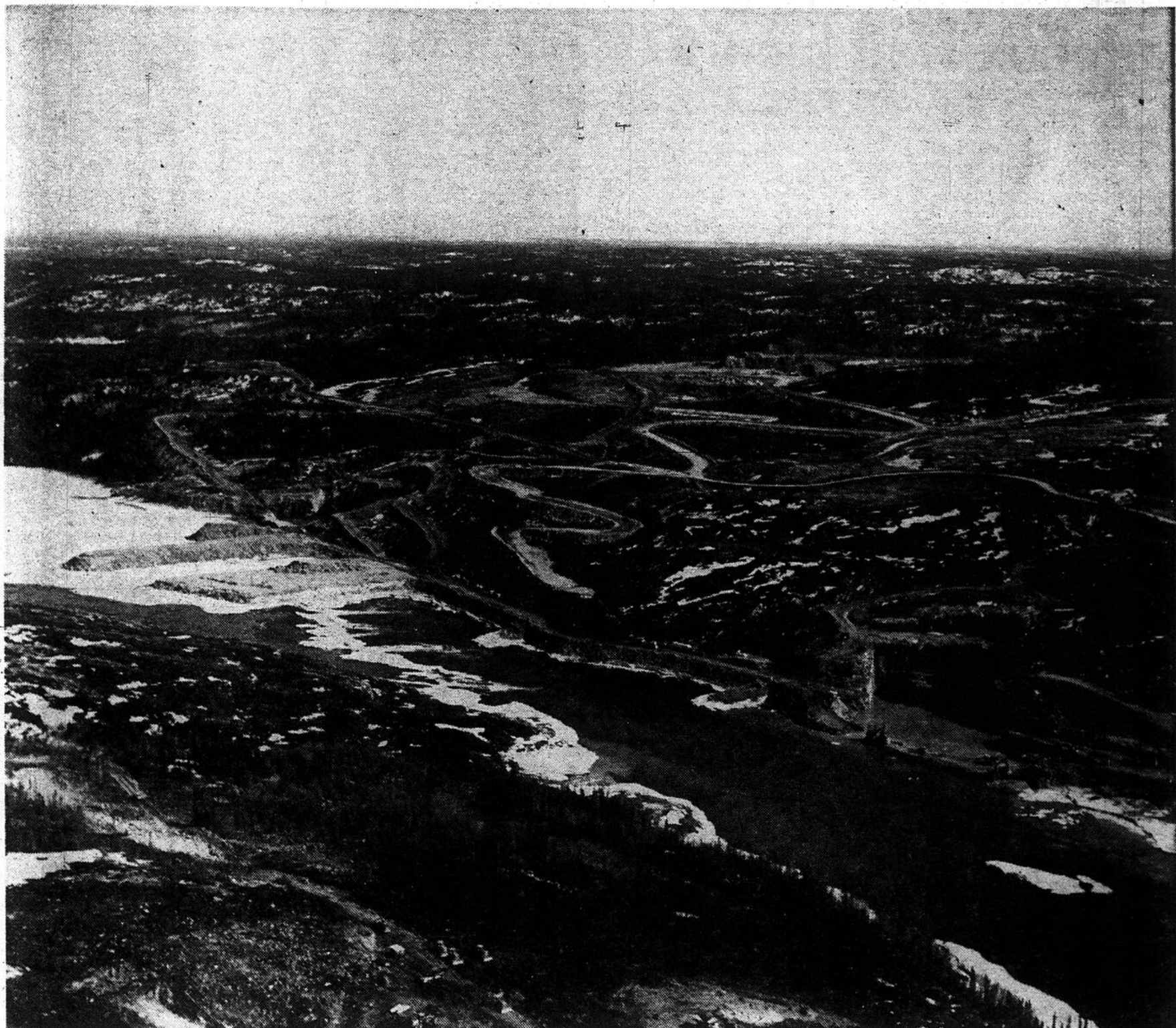
Comme le barrage de LG-2 sera souterrain, on y fait pénétrer l'eau dans des galeries de dérivation. Ici on aperçoit à droite le portail, d'aval et à gauche le batardeau, d'amont et les jetées de protection qui sont en construction.
