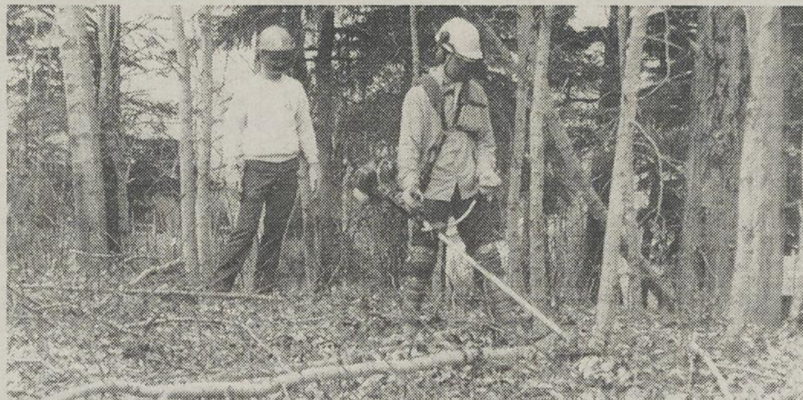
TRAVAUX — Tout en mettant en pratique des techniques apprises dans leurs cours, ces étudiants en techniques forestières travaillent à améliorer l'aspect sécuritaire des sentiers reliant le Cégep de Chicoutimi à l'UQAC.
