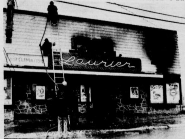
Du théâtre Laurier, il ne reste plus que la façade. Son propriétaire, M. Fernand Pruneau venait tout juste d'y investir une petite fortune pour faire installer un système de climatisation.
