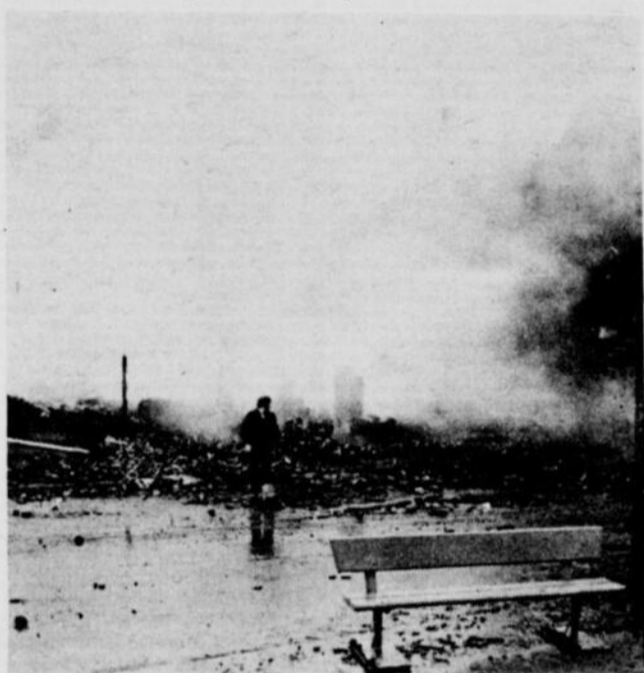
La Brasserie Victoria aura été rasée jusqu'au sol par l'incendie.
