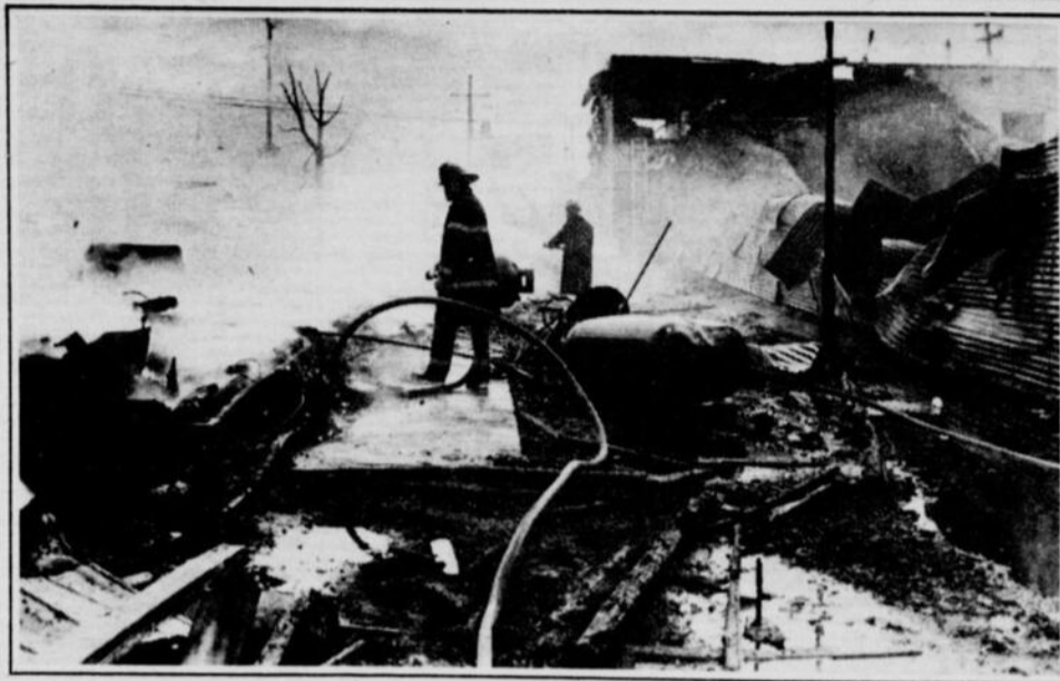
De la salle de quilles, il ne reste plus que des ruines.
